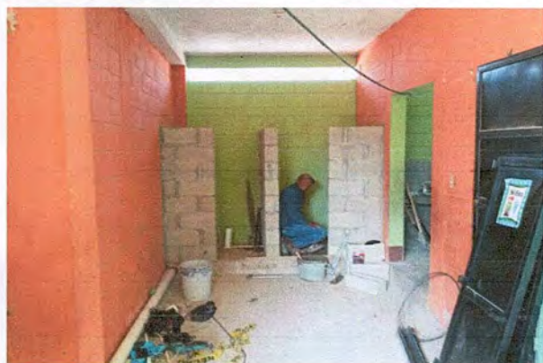
Foto 3: Reparación de los sanitarios
