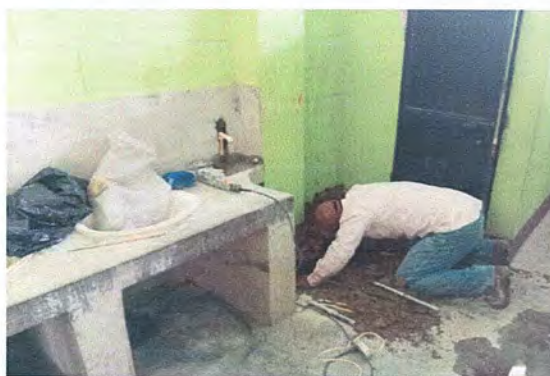
Foto 2: Reparación de los lavamanos
