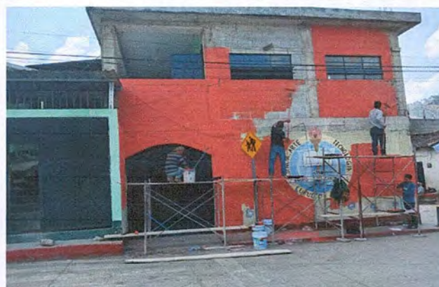
Foto 4: Inicio de la pintura del establecimiento
