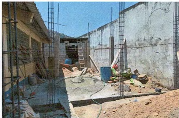
Foto 1: Proceso de reparación de la cocina
